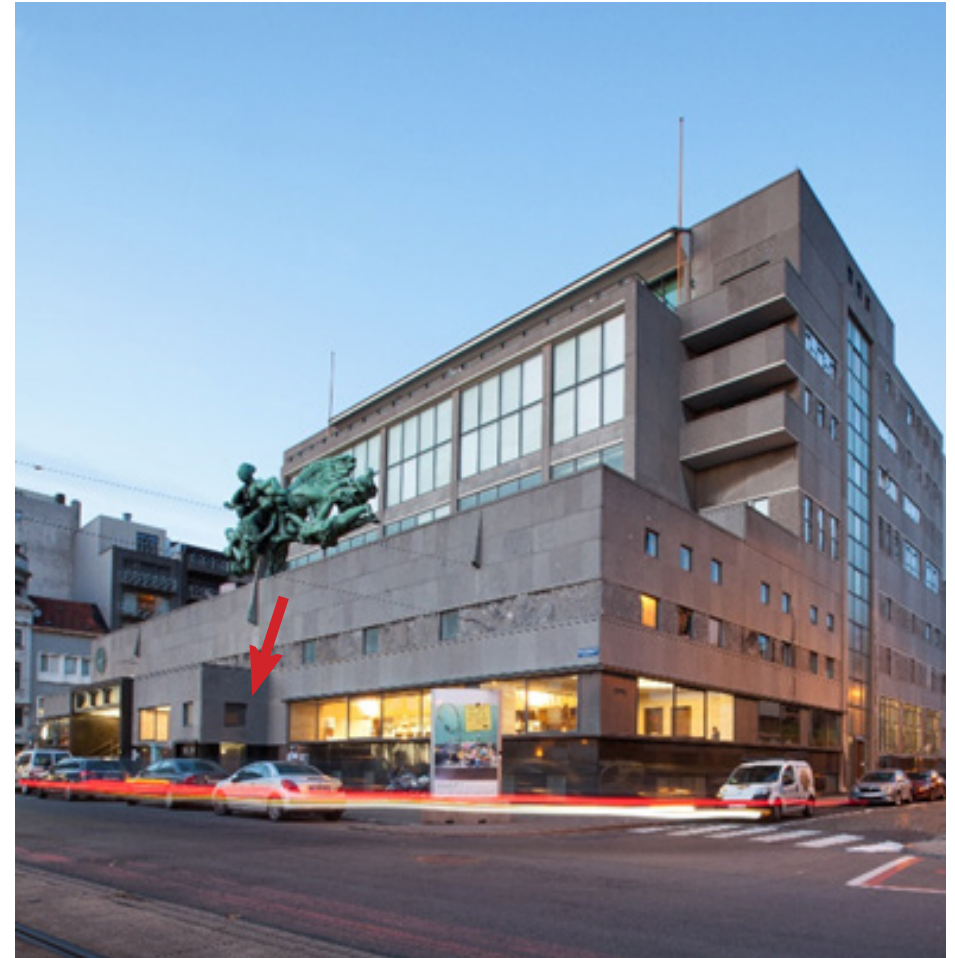
Lift van straatniveau naar de lokettenzaal
